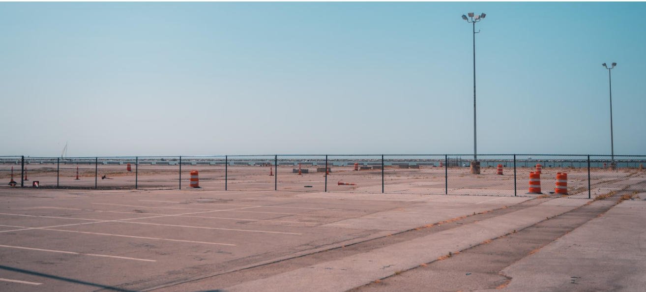
一片没有一棵树的沥青场地。这样的表面白天比遮阴处升温高得多，且几乎不透水：全部降雨在数分钟内到达雨水管网，形成的正是管网必须据以设计的那个峰值。
